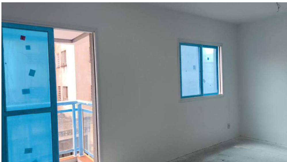
[FOTO 05 – Sala/Quarto + Terraço / vista em sentido oposto ao da foto 04]
