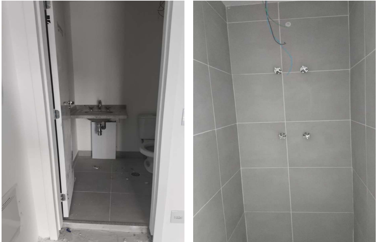
[FOTO 08/09 – Vistas parciais do Banheiro]
