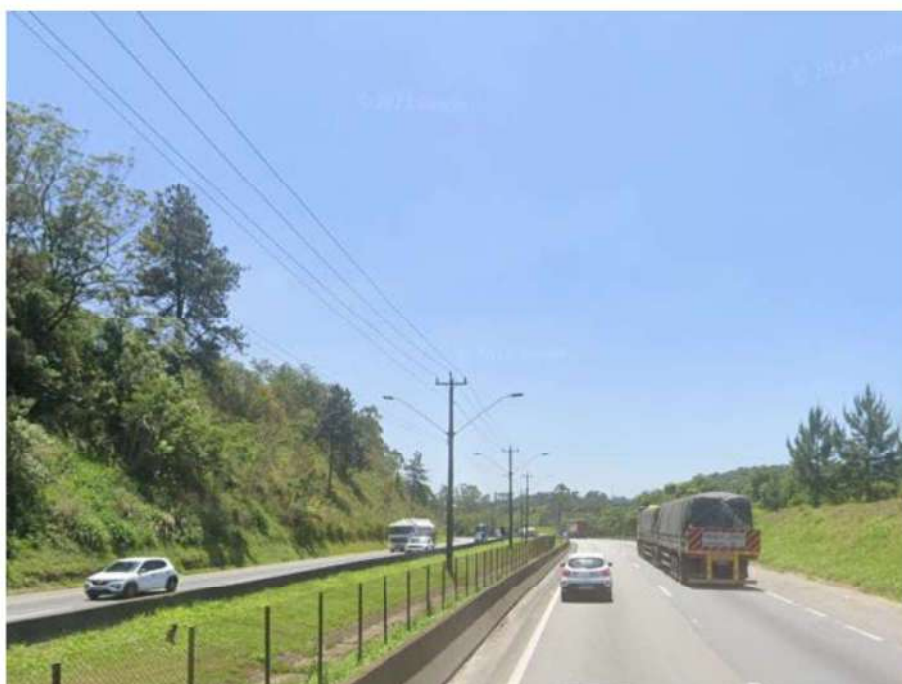
Foto nº. 1 – Vista da Rodovia Regis Bittencourt (km 294), onde se localiza o imóvel avaliando.
