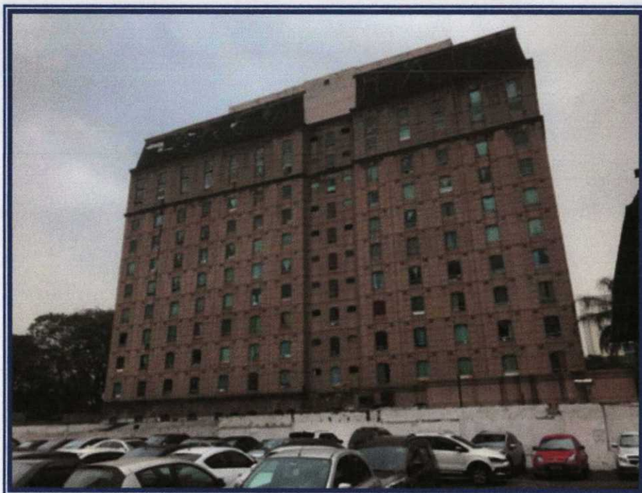
Vista geral do prédio do imóvel.
