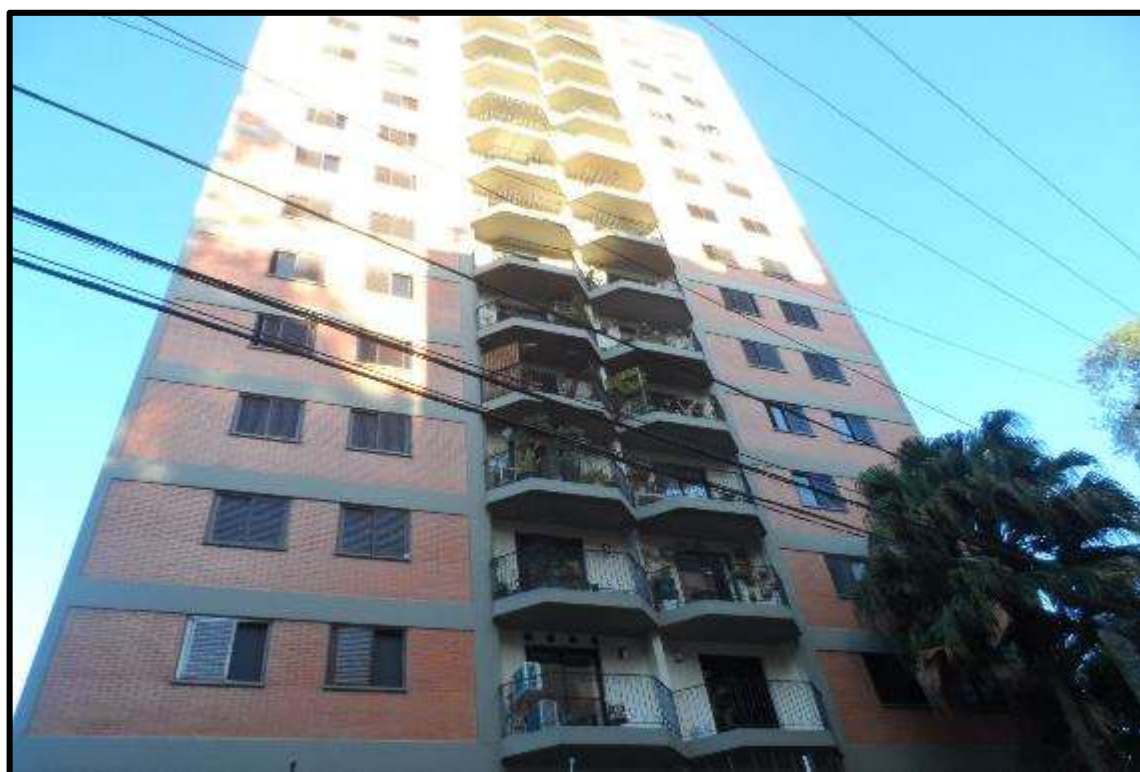
FOTO 4 – Vista geral da fachada do edifício.
