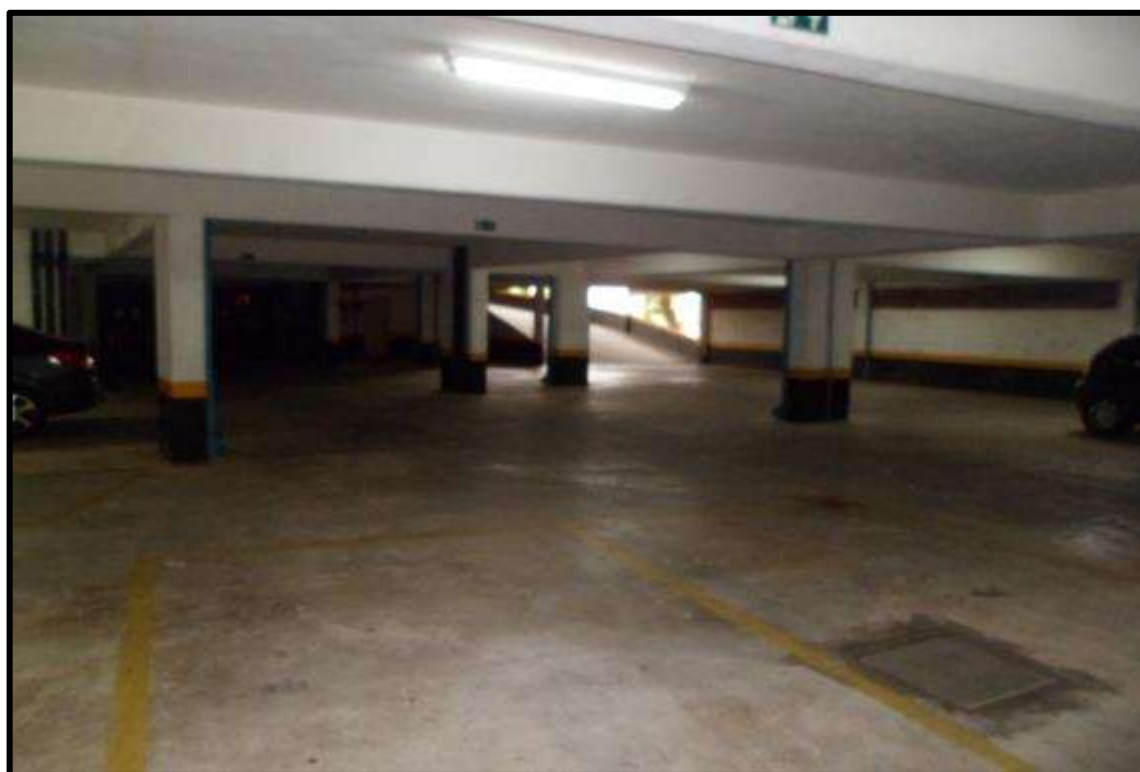
FOTO 28 – Vista geral da garagem.
