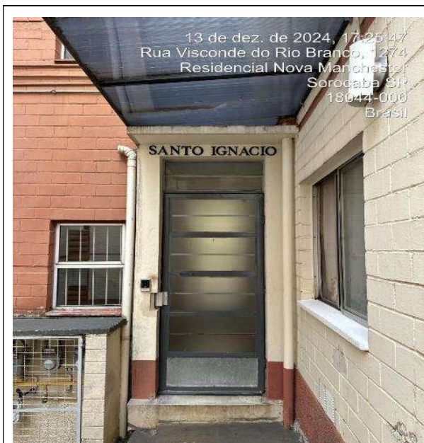
Foto 01 – Acesso ao Bloco
