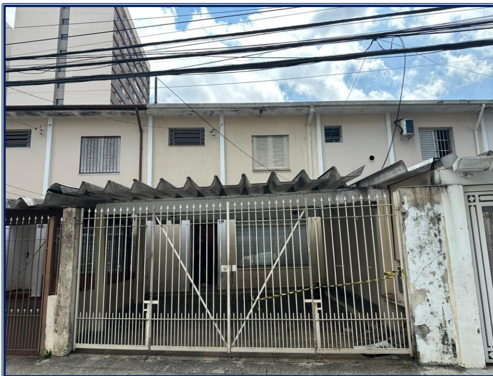
Vista da frente do imóvel
