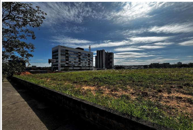
QUADRA U (parte dos lotes) - Rua 18
