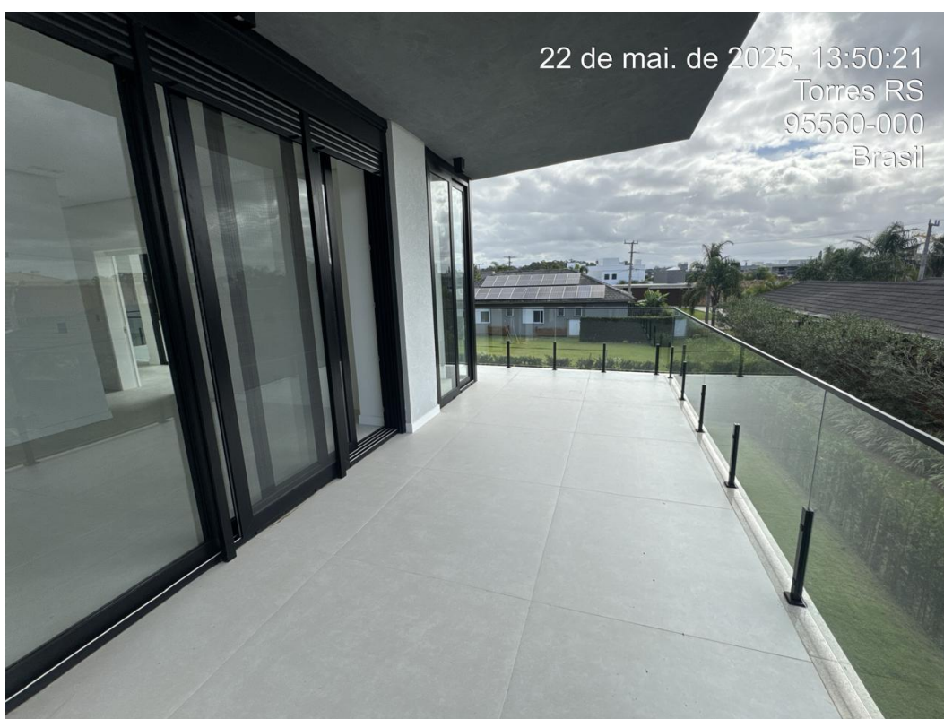
Foto superior: vista geral do imóvel
