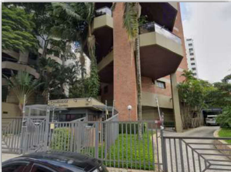
Vista da entrada do Condomínio Edifício Cambridge Gardens
